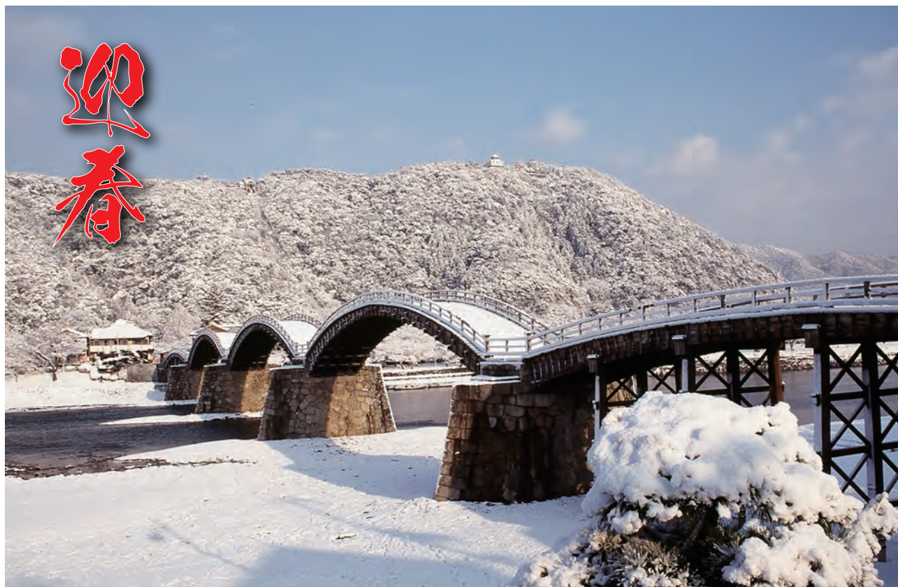
岩国市 錦帯橋
